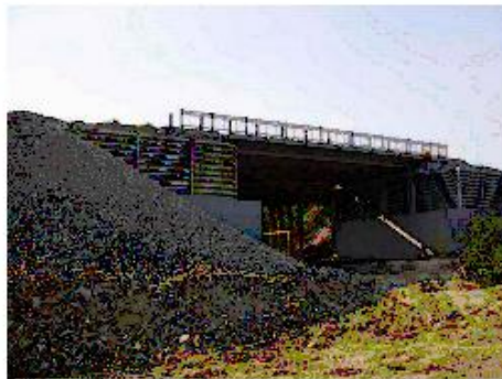
Рис. 2.1 Использование ССТГ в качестве устоя путепровода через железную дорогу на автодороге Екатеринбург – Ржев – Алапаевск в Свердловской области.
