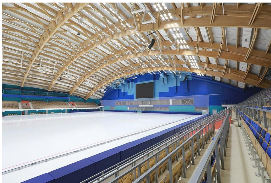
Рис.1. Стадион «Енисей», г. Красноярск. Покрытие по клееной деревянной арке пролетом 100м.
